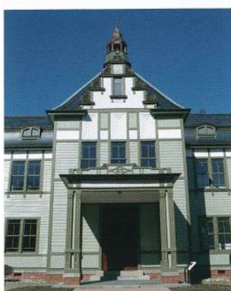
写真7 研究所本館正面切妻階段状破風
