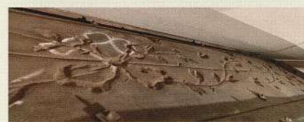
写真12 型押しのあとがわかる西一之間の暖炉内枠裏面
