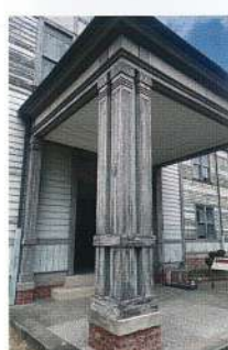
写真10 玄関バルコニーの柱の条溝部分
