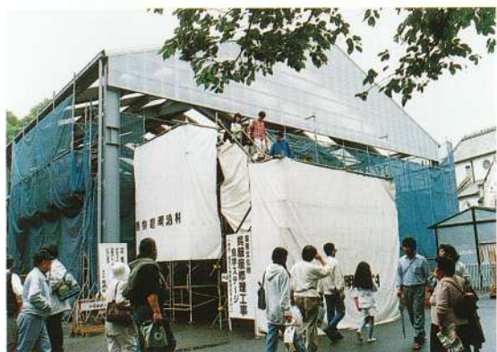
素屋根の前には、屋根工事見学のステージを組んだ
