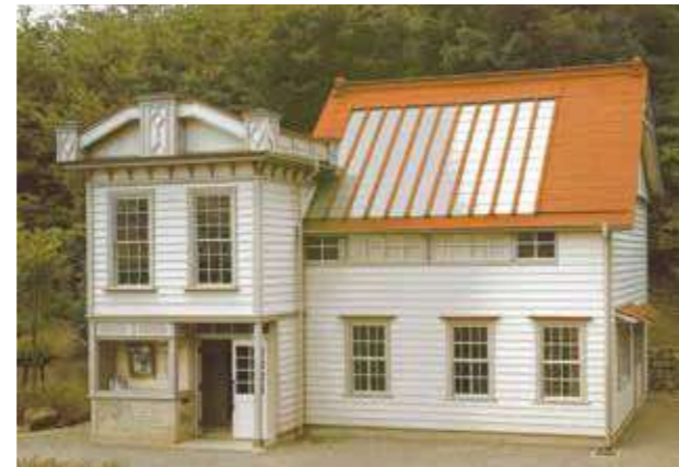
写真3 移築当時の高田小熊写真館
