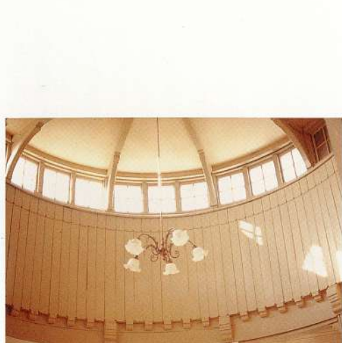
写真4 円錐屋根内部
