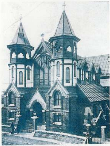
写真1 建築当初の外観 （『建築世界』第3巻第11号口絵より）
