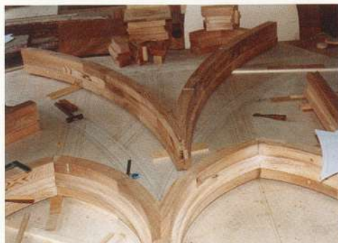
写真5 木工所で製作中の窓枠
