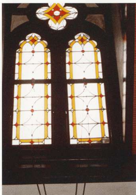
写真4 ドームウィンドーのステンドグラス修理後
