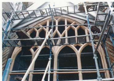
写真6 窓枠の取り付け完了
