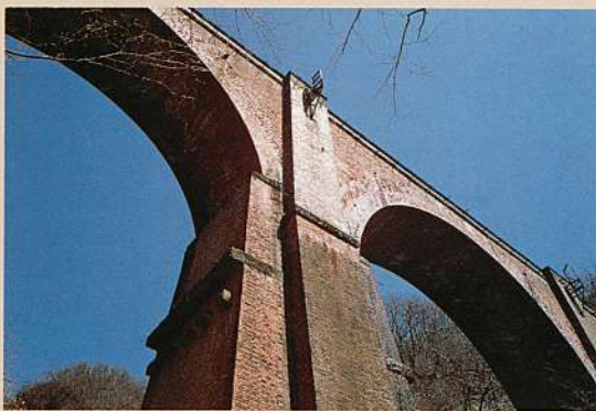
旧碓氷線第三橋梁<重要文化財>(明治26年、群馬県松井田町)
