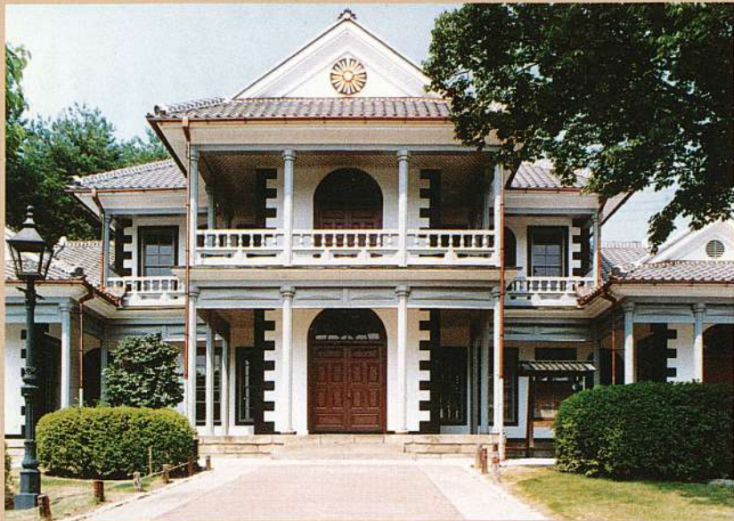
6 東山梨郡役所全景(平成7年修理後)
