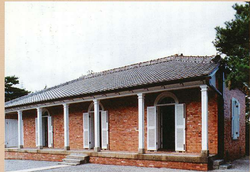
1 菅島燈台付属官舎全景(平成6年修理後)
