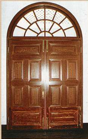
9 修理後(扉の下部は当初のニス木目塗りを保存した)
