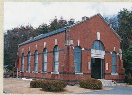
5丁目 ⑥ 名鉄岩倉変電所(岩倉ホール) 旧所在地 / 愛知県岩倉市下本町 建築年 / 明治45年(1912) 移築年 / 昭和50年
