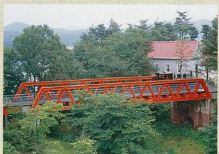
4丁目 ㉖ 六郷川鉄橋 旧所在地 / 東京都蒲田・神奈川県川崎間の六郷川 建築年 / 明治10年 (1877) 移築年 / 昭和63年
