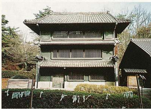
修理前の東松家住宅
