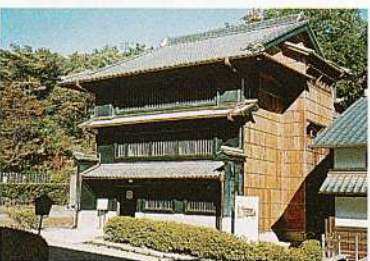
修理後の東松家住宅
