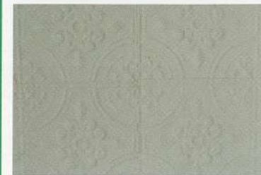
2階 バルコニー天井
