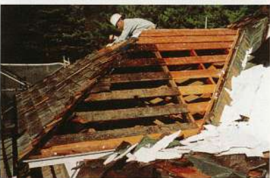
旧材除去後 野地板間隔は葺き足に合わせてある。
