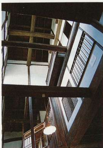
写真2 東松家住宅土間吹き抜き層構成の中に自然光をたくみに取り入れている
