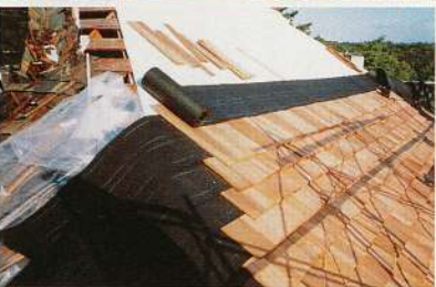
耐火ボードを敷き込み、その上にアスファルトフェルトを敷き込みつつ、板張り
