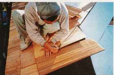
耐火ボードを敷き込み、その上にアスファルトフェルトを敷き込みつつ、板張り
