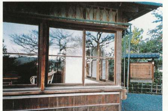
写真5 坐漁荘サンルーム 雨戸が廻る出隅
