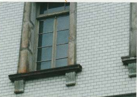
(写真2) 2階部分の白色タイル
