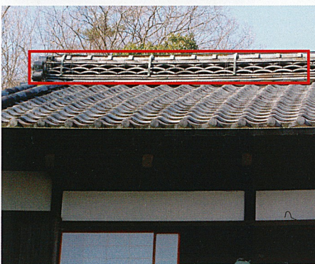
写真6 本郷喜之床の棟込瓦
