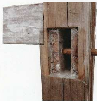
写真10 二階柱 差し丸留め
