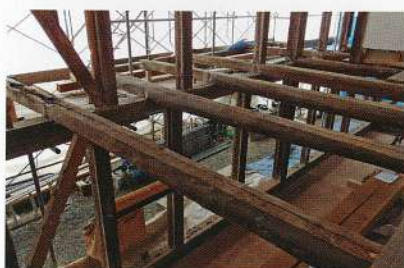
写真2 二階床梁(ベランダ持出梁)
