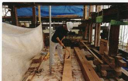
写真8 セラガンバツの新仕上げ
