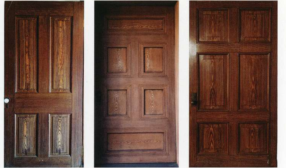
写真10 明治村内の類例建物全目塗が用いられた扉（左から菅島燈台附属官舎、東山郡役所、三重県庁舎）
