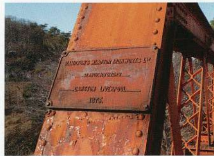
写真17 六郷川鉄橋のプレート
