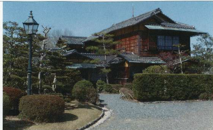
写真1 修理前南側全景
