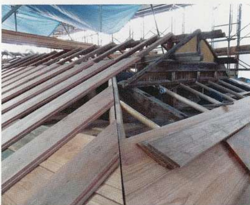
写真8 台所部分屋根下地の復旧
