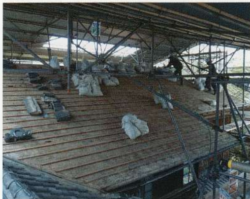
写真5 屋根既設瓦捲り状況
