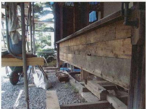
写真12 サンルームの土台取替え状況
