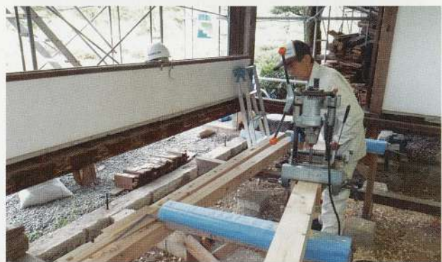
写真11 サンルームの新補土台加工
