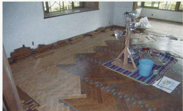
写真9 接室の床板捲り
