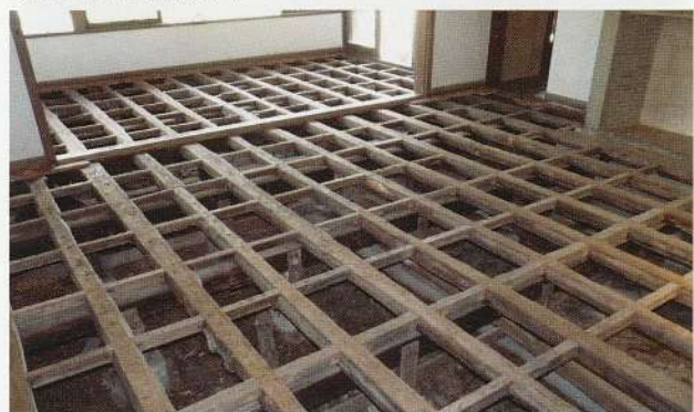
写真10 応接室の床組状況
