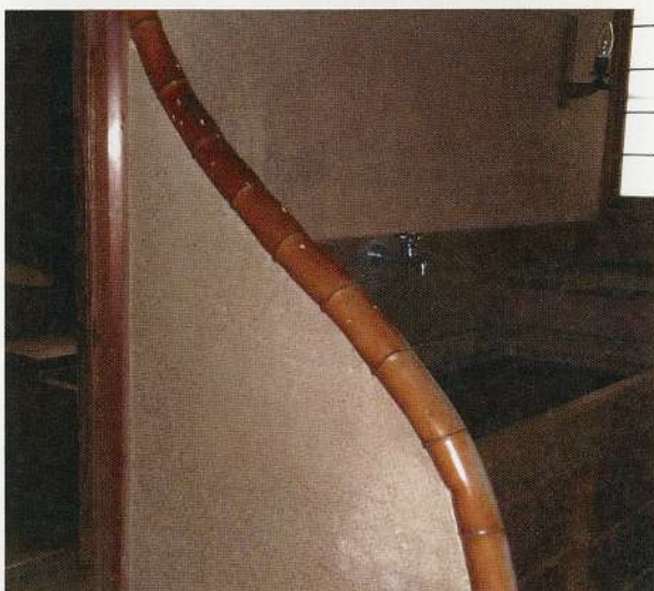
写真13 化粧室曲竹のタケトラカミキリによる虫害状況
