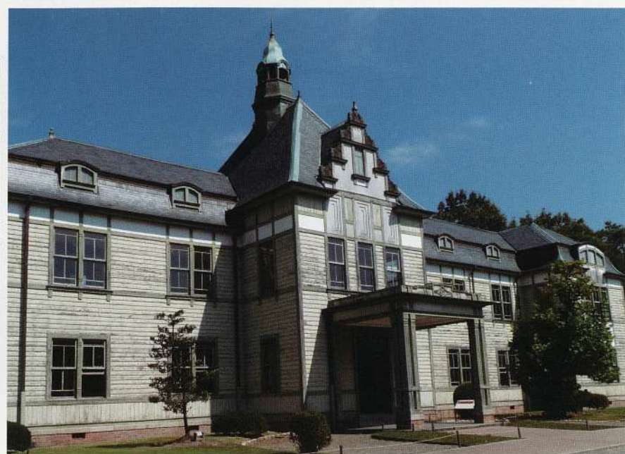
写真1 修理前全景（南西より見る）
