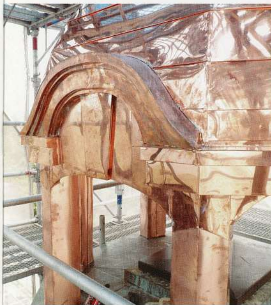
写真4 塔屋銅板葺替終了
