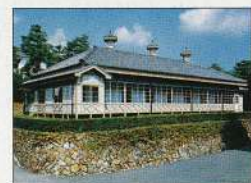
日本赤十字社中央病院病棟 建設年 明治23年(1890) この中央病院は、わが国が明治19年(1886)に万国赤十字条約に加盟した際、皇室から賜った御料地に建てられた大規模病院である。設計監督は、赤坂離宮の設計者であり、日本最初の建築家4人のうちのひとり、片山東熊である。
