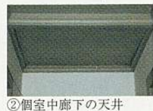
②個室中廊下の天井
