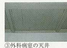
③外科病室の天井
