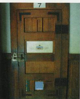
金沢監獄監房(独居房)の扉
