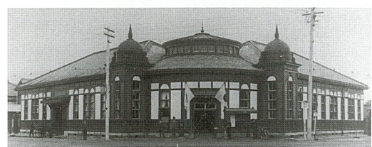
写真1 移築前写真(大正4年)
