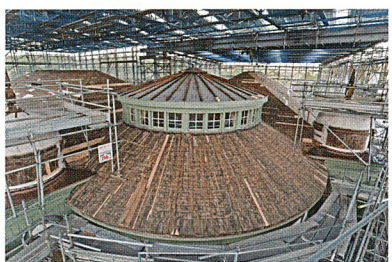
写真5 中央ドーム屋根下地
