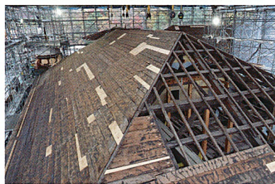
写真8 野地板の補修
