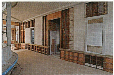
写真3 電信機械室の耐力壁
