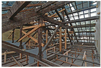
写真2 小屋組補強状況
