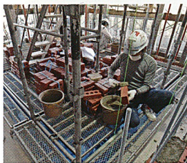
写真16 煉瓦積施工状況
