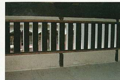
写真3 虫籠窓内部の無双窓
