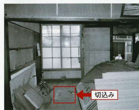
写真5 一階待合室から薬局を見たところ(解体時)
