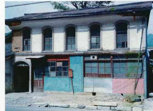
写真2 解体時の清水医院正面
