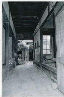
写真6 一階玄関土間から主屋玄関を見たところ(解体時)
