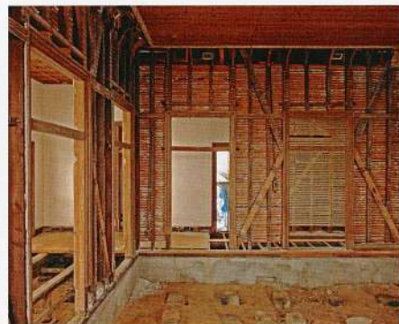
写真9 構造用合板を設置するため解体された別館内部壁面
