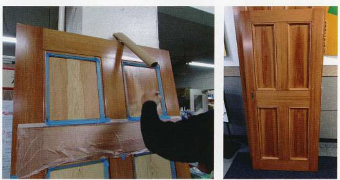
写真4 杢目塗復原の施工状況。均一に塗られた下地に晩材の線を描いている様子(左)と完成(右)
