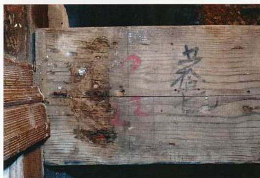
写真12 本館床梁上面に記された「五拾七」の番付墨書。この床梁と組み合う柱番号を示す
