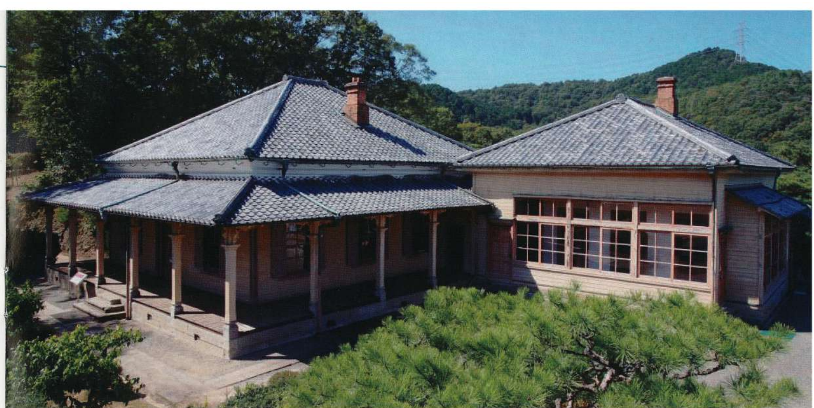
平成27年修理前外観 左:本館、右:別館
