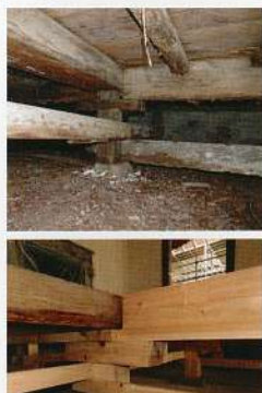
写真11 本館床下の修理前(上)と修理後(下)
