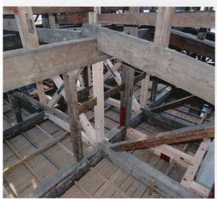
写真8 本館小屋組の耐震補強
