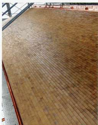
写真4 屋根木賊葺 修理後
