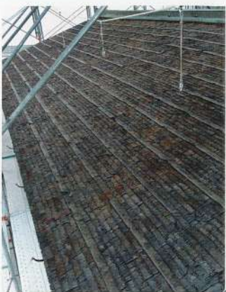
写真3 屋根木賊葺 修理前
