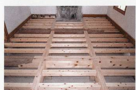
図10 本館床組修理後
