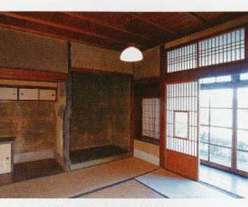
図5 別館和室修理前内観
