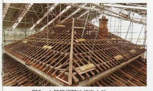
図6 本館屋根野地板撤去後
