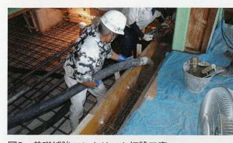
図8 基礎補強コンクリート打設工事
