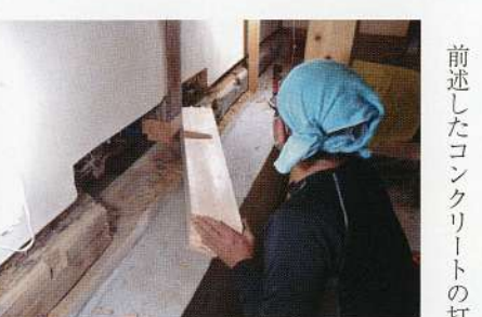
図9 別館土台取り替え作業
