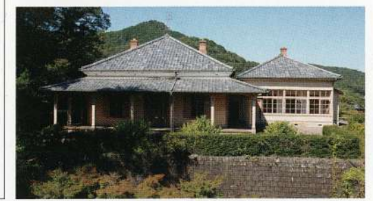
図1 修理前正面外観(左:本館、右:別館)
