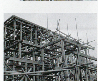
写真5 移築工事中の従道邸
