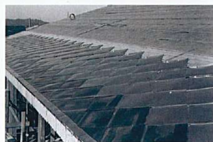
屋根の銅版敷き
