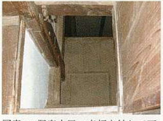
写真2: 洞庫水屋の床板を外して下(二階天井)を見た様子
