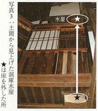
写真3: 土間から見上げた洞庫水屋 ★は床を外した所
