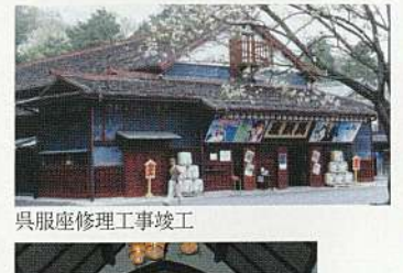
呉服座修理工事竣工
