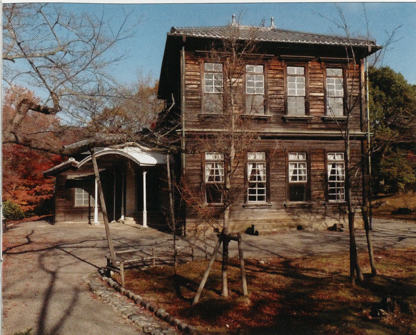
写真1 修理前南側全景
