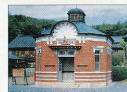
東京駅警備調査派出所 建設年 大正3（1914）年頃 東京駅の開業に合わせ、駅舎のデザインと調和を図るよう意識して設計された。外壁はレンガではなく化粧レンガを用いており、当時最先端の仕様であった。国貨などの利用が多い東京駅を護るため、10人を越える巡査が詰めていたといわれる。
