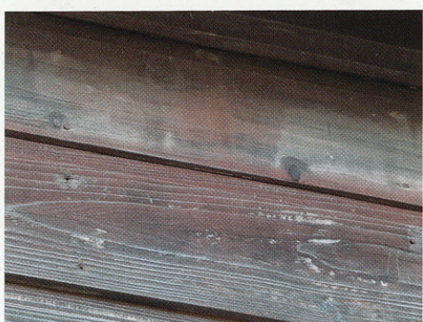
写真5 南面洋館下見板に残る旧塗膜の痕跡
