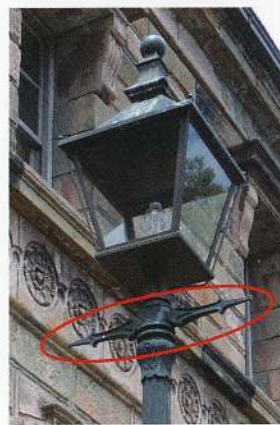
写真4 灯器下の「かんざし」
