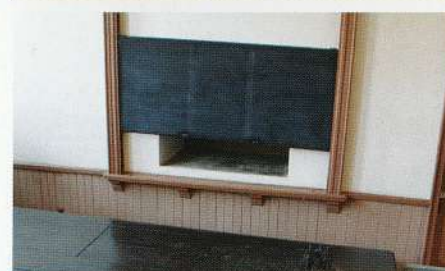
化学教室の黒板裏側に設けられたドラフトチャンバー ドラフトチャンバー内の煙道
