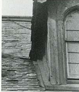
写真3 天然スレート葺き屋根
