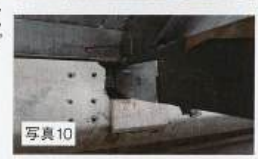
写真10 トラス陸梁端部の修理
