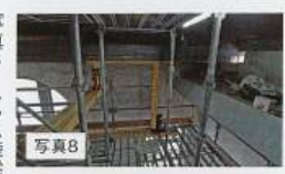
写真8 トラス陸梁端部の修理
