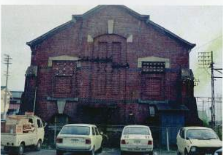
写真2 解体前写真(背面)
