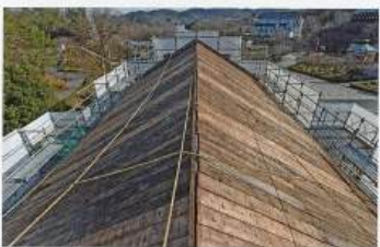
写真6 天然スレート解体後野地板の状況
