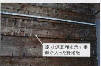
写真7 煉瓦積層寸を示す墨線
