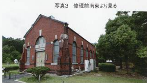
写真3 修理前南東より見る
