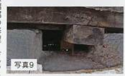
写真9 トラス陸梁端部の修理
