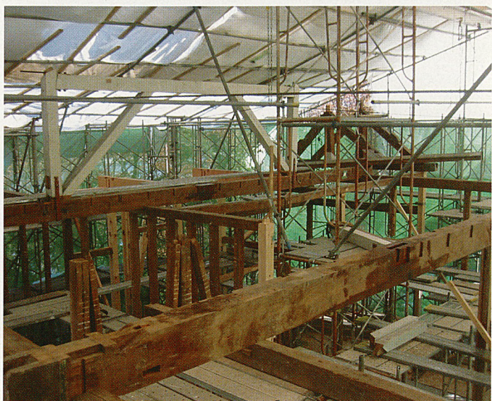
写真5 軸部組立ての様子2 三階部分の組立
