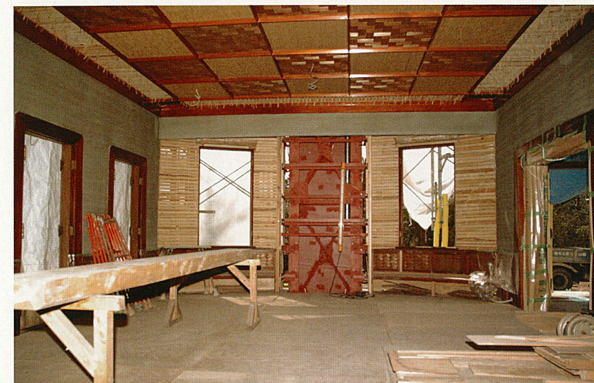
写真7 一階客室・食堂 格天井が組上がり、奥には煙突の鉄骨下地が見える
