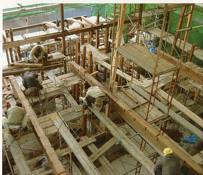
写真4 軸部組立ての様子1 二階部分の組立
