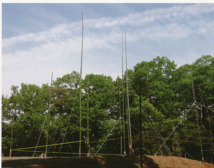
写真3 竹による建物外形の仮組み
