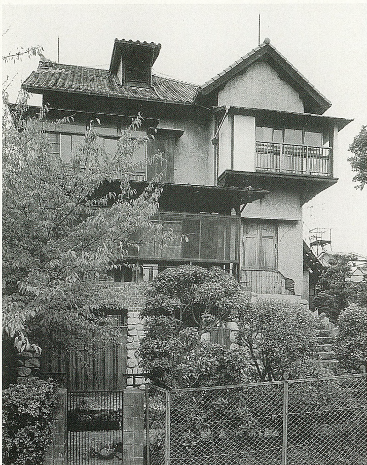
解体前の芝川邸（北面）
