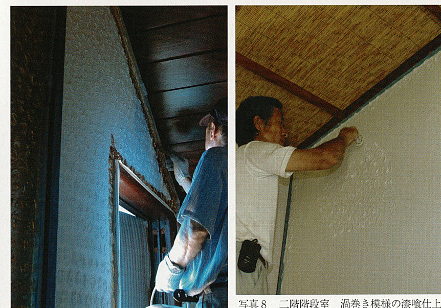
写真8 二階階段室 渦巻き模様の漆喰仕上げ復原のため特殊な道具を考案していた 写真9 二階階段室 金色塗装仕上げ1
