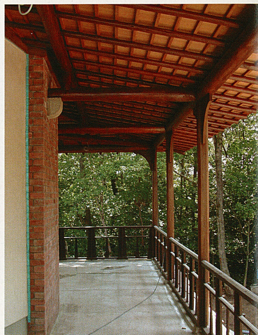
写真11 1階ベランダ東側を見る
