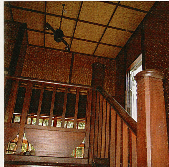
写真10 二階階段室 金色塗装仕上げ2
