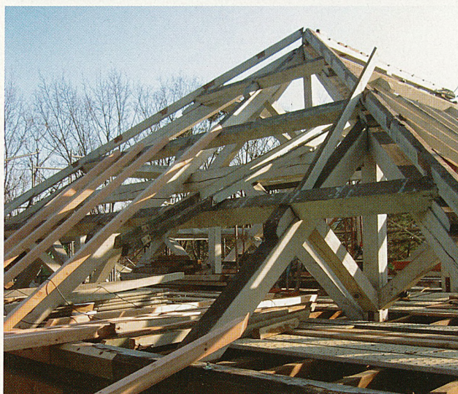
写真6 軸部組立ての様子3 屋根部分の組立
