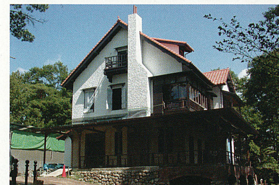
復原工事中(平成19年8月)
