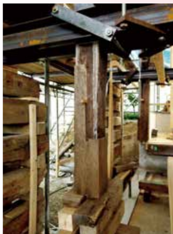
写真4 柱の根継ぎ
