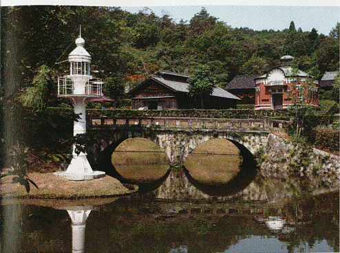
写真1 天童眼鏡橋修理前外観
