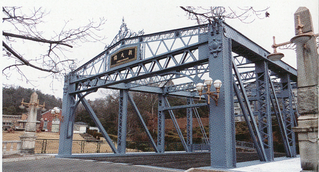
写真9 隅田川新大橋修理後
