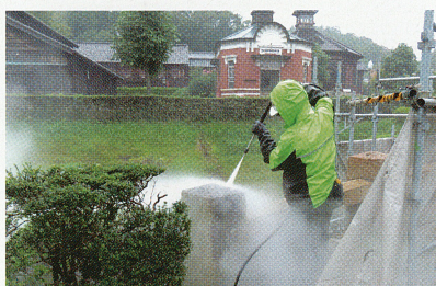
写真4 加圧超高温水洗浄風景
