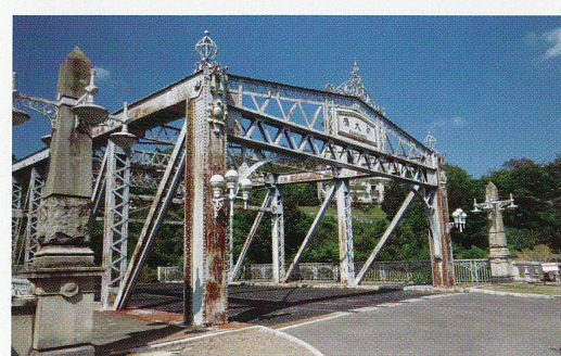
写真7 隅田川新大橋修理前
