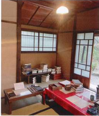
小書斎・明かり取り窓のアルコーブが化粧天井となつている
