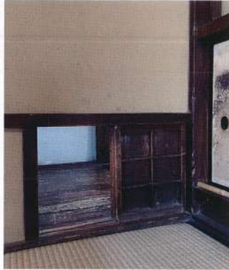
次の間と中廊下壁の潜り戸
