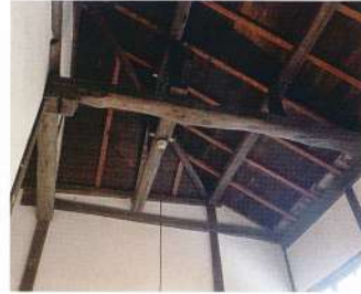
台所上部には小屋組がみえる
