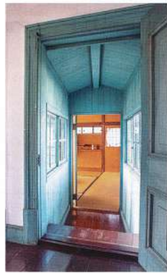
写真2 二階渡り廊下(主屋から付属屋)
