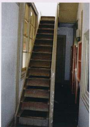
写真7 1階2階ともサービス通路が設けられている
