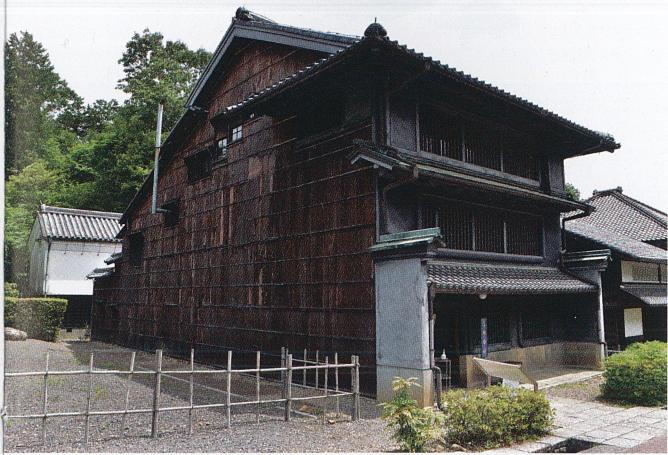
写真1 東松家住宅 正面から側面の通り庭への高窓開口部を望む
