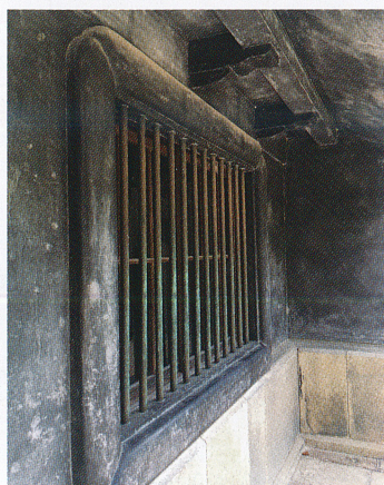
一階腰壁から上部分の黒漆喰の様子
