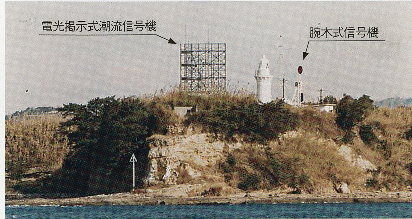
写真2 新設された電光掲式潮流信号機と解体前の台場鼻の腕木式信号機
