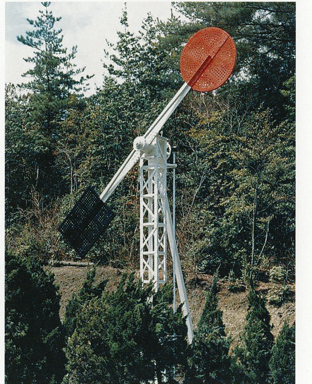
写真1 移築竣工時の台場鼻潮流信号機
