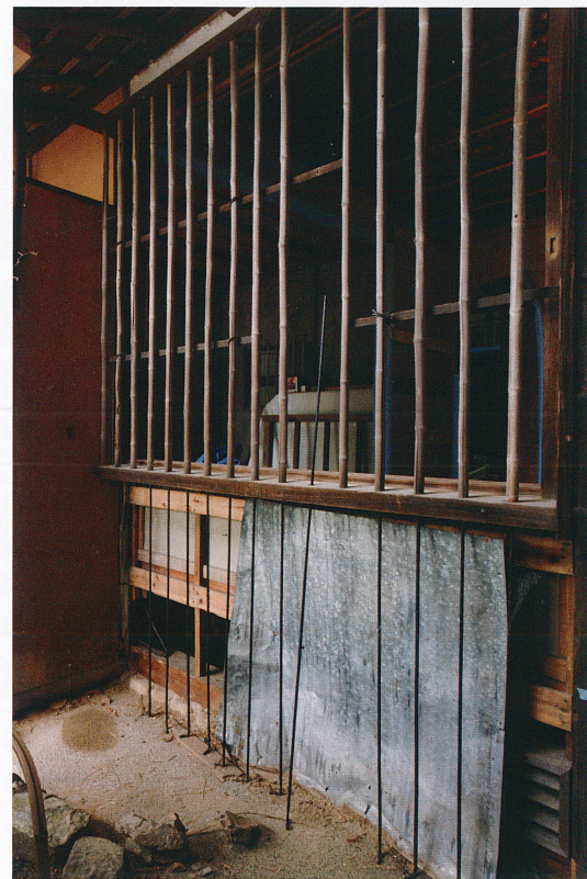
写真 外部造作 玄関竹格子及び鉄筋修理
