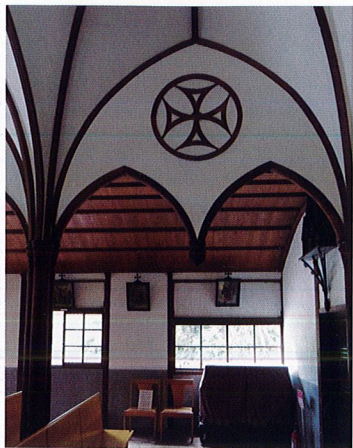
身廊部の尖塔アーチ
