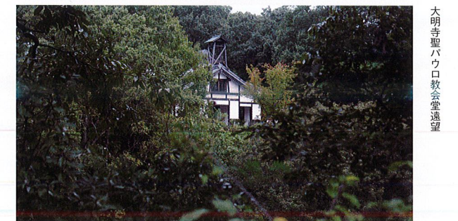
大明寺聖パウロ教会堂(5丁目56番地)登録有形文化財 旧所在地:長崎県西彼杵郡伊王島町 建築年 明治12年(1879年) 解体年 昭和50年(1975年) 移築年 平成6年(1994年) 登録年 平成16年(2004年)
