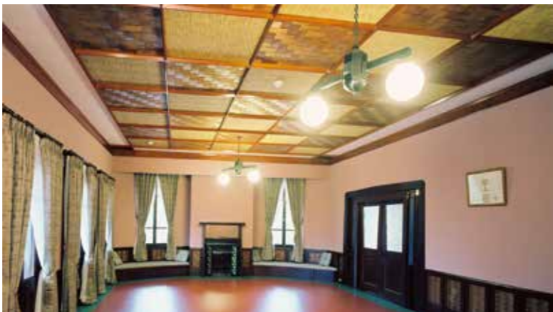
写真4 一階客間・食堂 椀板の網代と葦簀を市松状に配した格天井
