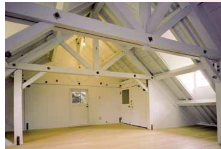
写真11 屋根裏 強化金具は彩色している
