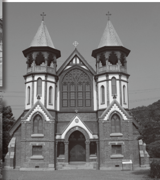
建物等の修繕
