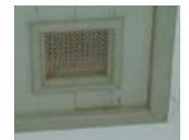
写真2 天井の換気口
