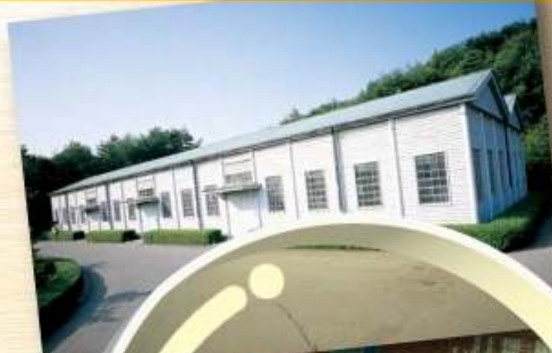
鉄道寮 新橋工場・機械館 東京 1872(明治5)年
